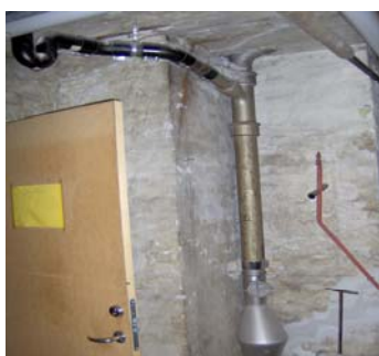
Rottespærre monteret gl. faldstamme. Rør til gulv afløb udskiftet.
